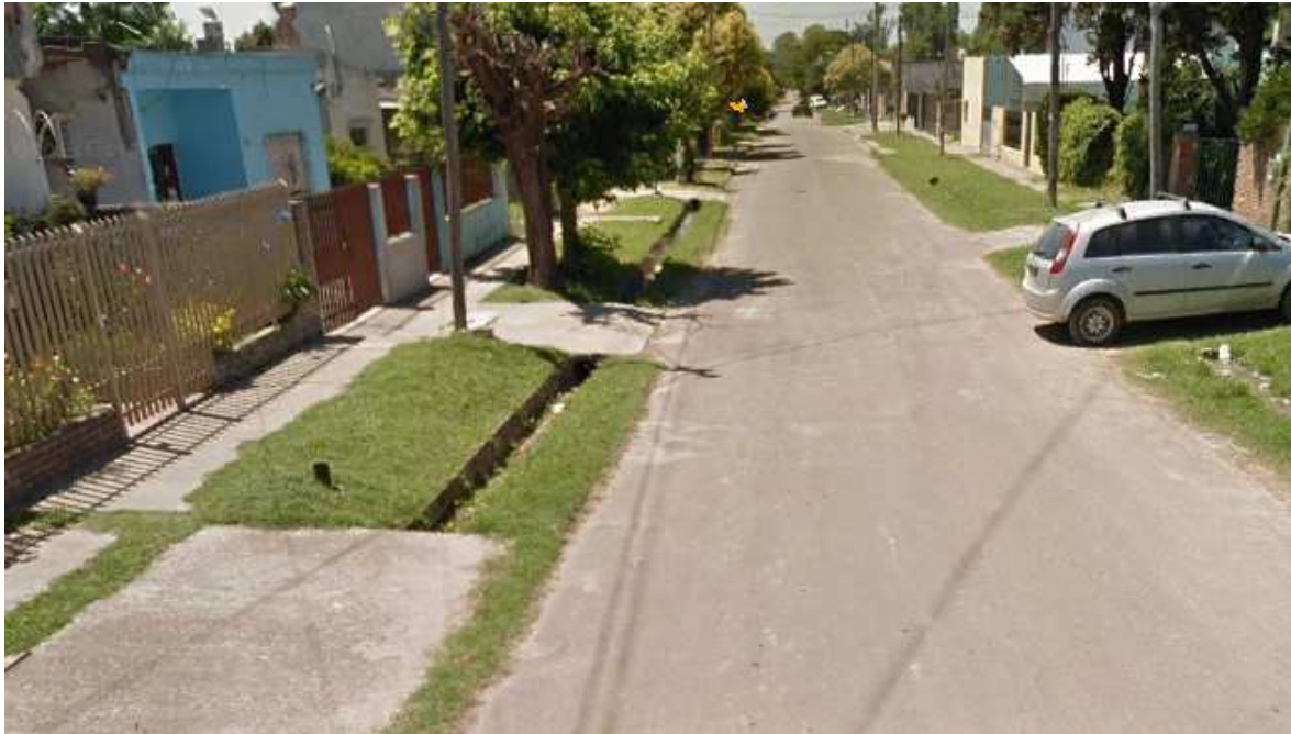
Figura 30: Asfalto sin cordón cuneta sobre calle El Ceibo.
