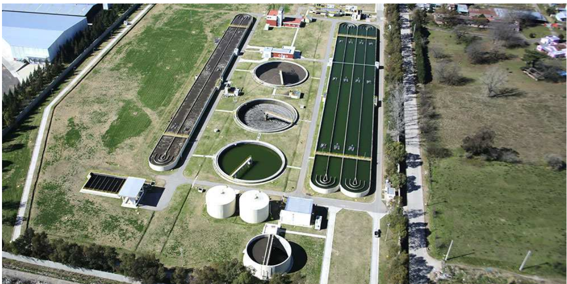
Figura 4b: Vista area de la planta Depuradora Catonas – Partido de Moreno
