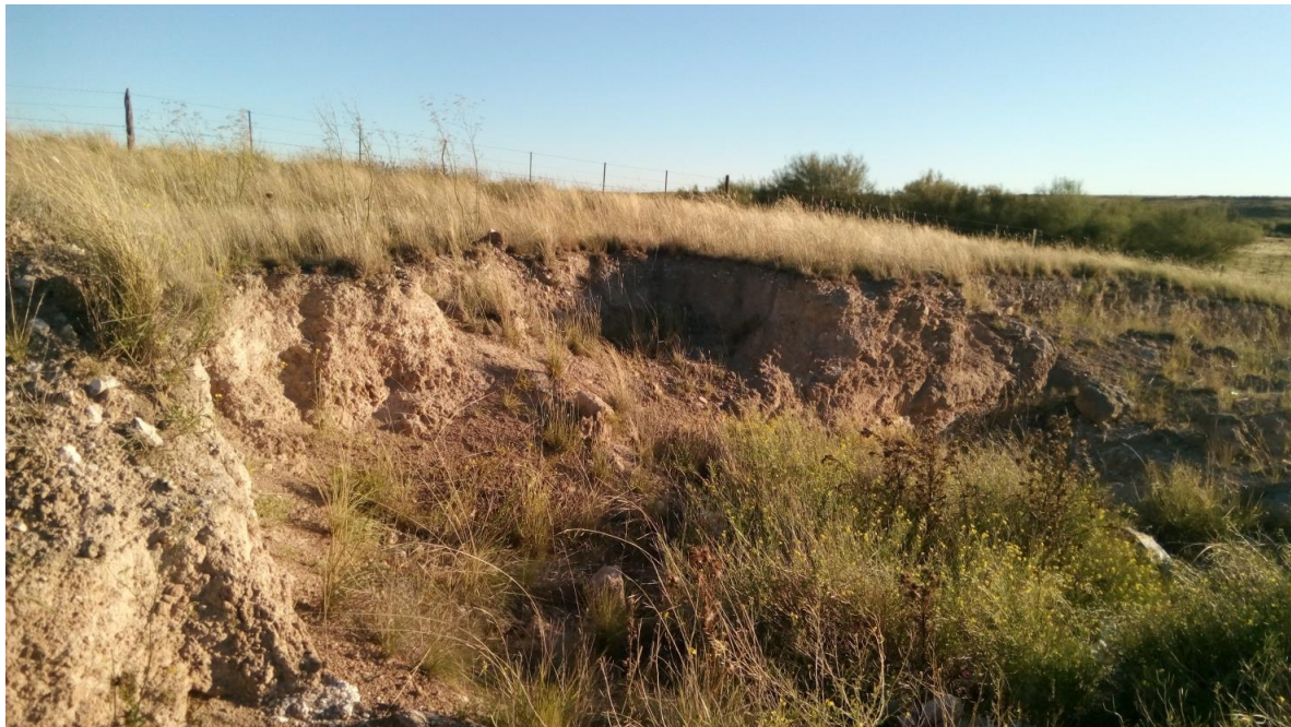
Figura 27: Corte en la Ruta N° 3 de antiguas terrazas
