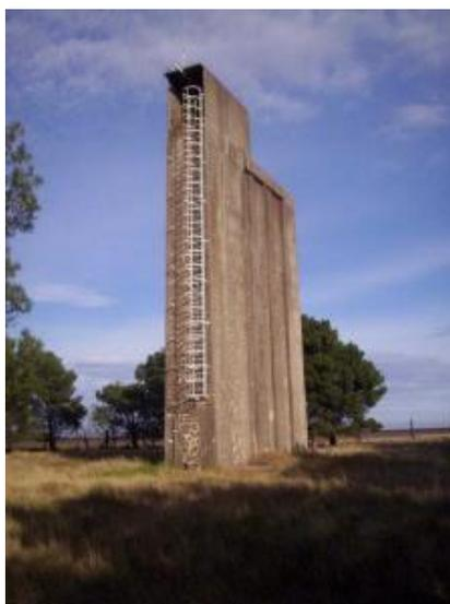
**Figura 5: Acueducto Principal – Hormigón Pretensado**
