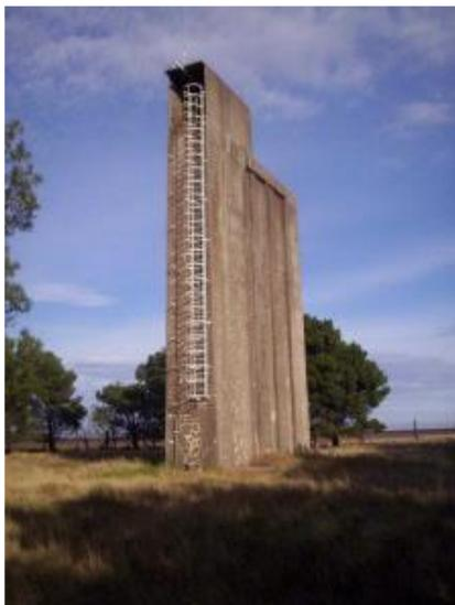
**Figura 5: Acueducto Principal – Hormigón Pretensado**
