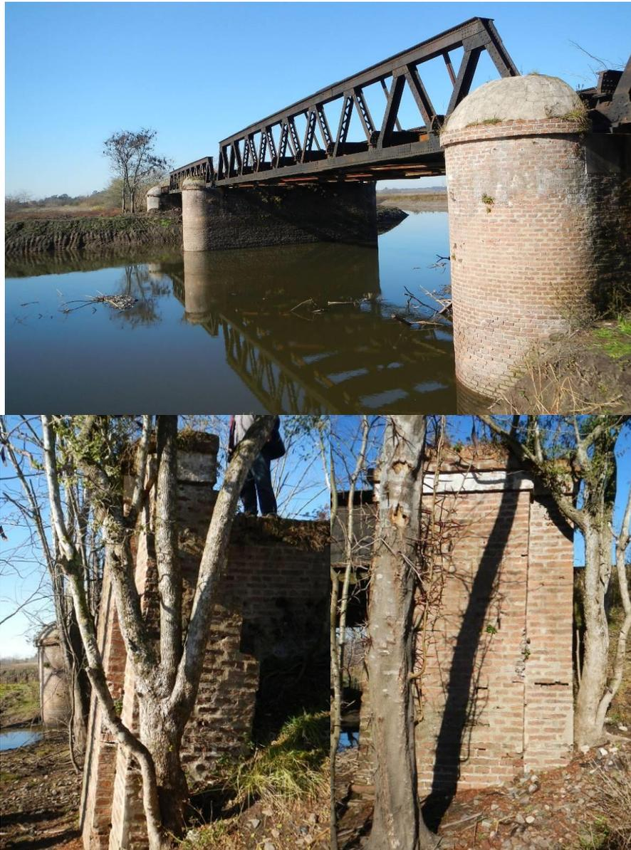
**Figura 4: Puente principal actual: a) Pilas correspondientes al tramo central, b) Estribos**
