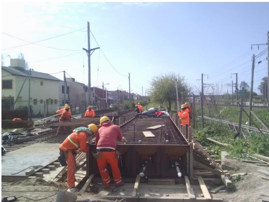
**Figura 14: Armado de Viga de puente ferroviario. Se colocan las vainas con cables de pretensado.**
