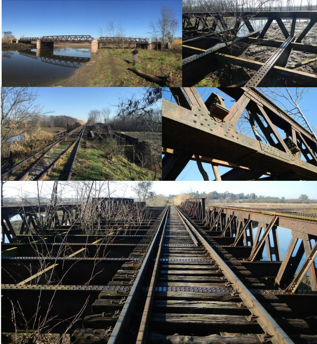
**Figura 3: Puente principal actual: a) *Vista general del puente* y b) *Detalle de Tablero Abierto (Tramos intermedios)*, c) *Vista superior en dirección longitudinal*, d) *Vista inferior Reticulados Intermedios*, e) *Detalle del tablero abierto, durmientes y rieles*.**
