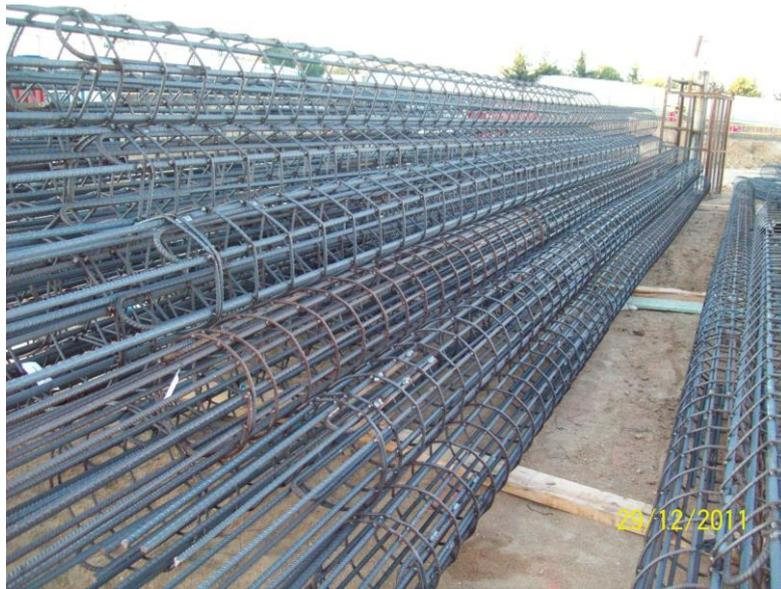
**Figura 11: Acopio de armadura en banco de trabajo**
