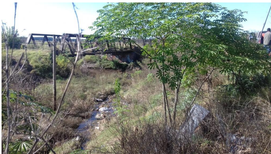
Zanja de desagüe Margen izquierda Aguas arriba
