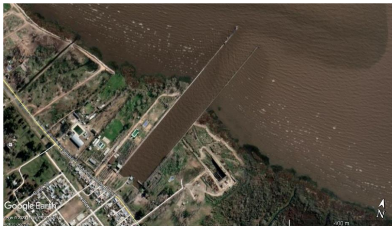
Figura 3: Imagen Satelital – Canal y Toma de agua Planta Potabilizadora.
