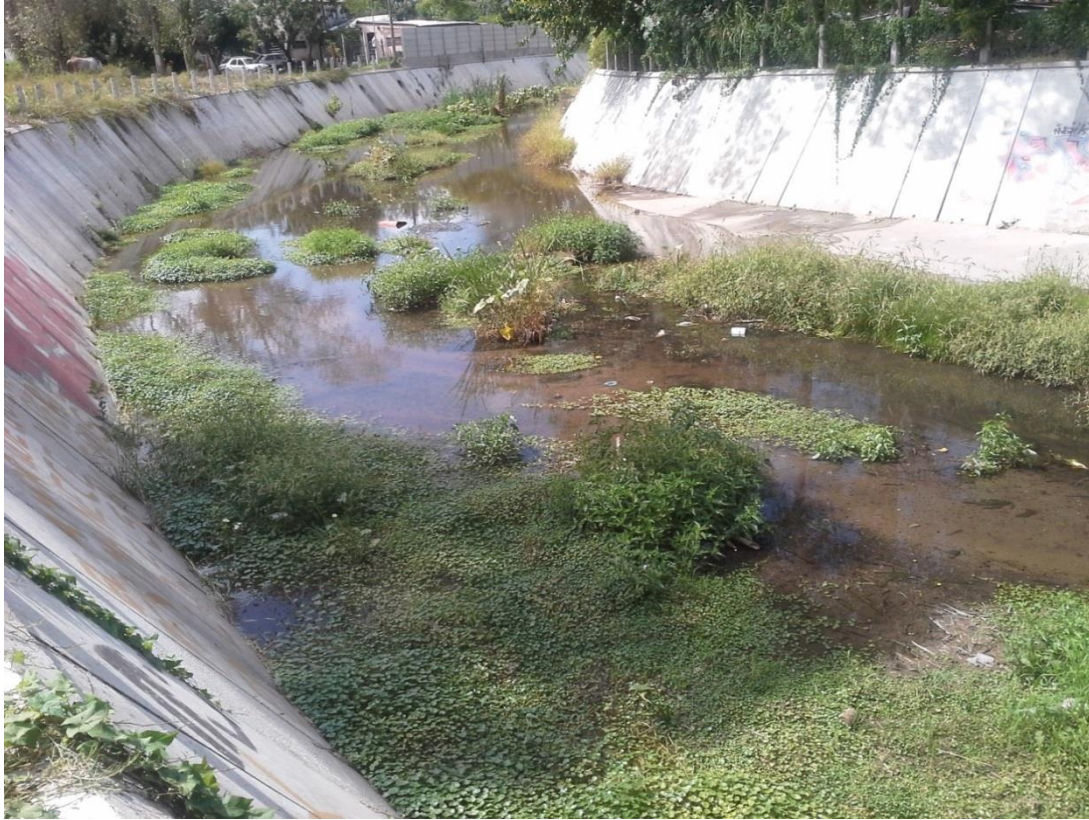
Figura 21: Arroyo Carnaval canalizado
