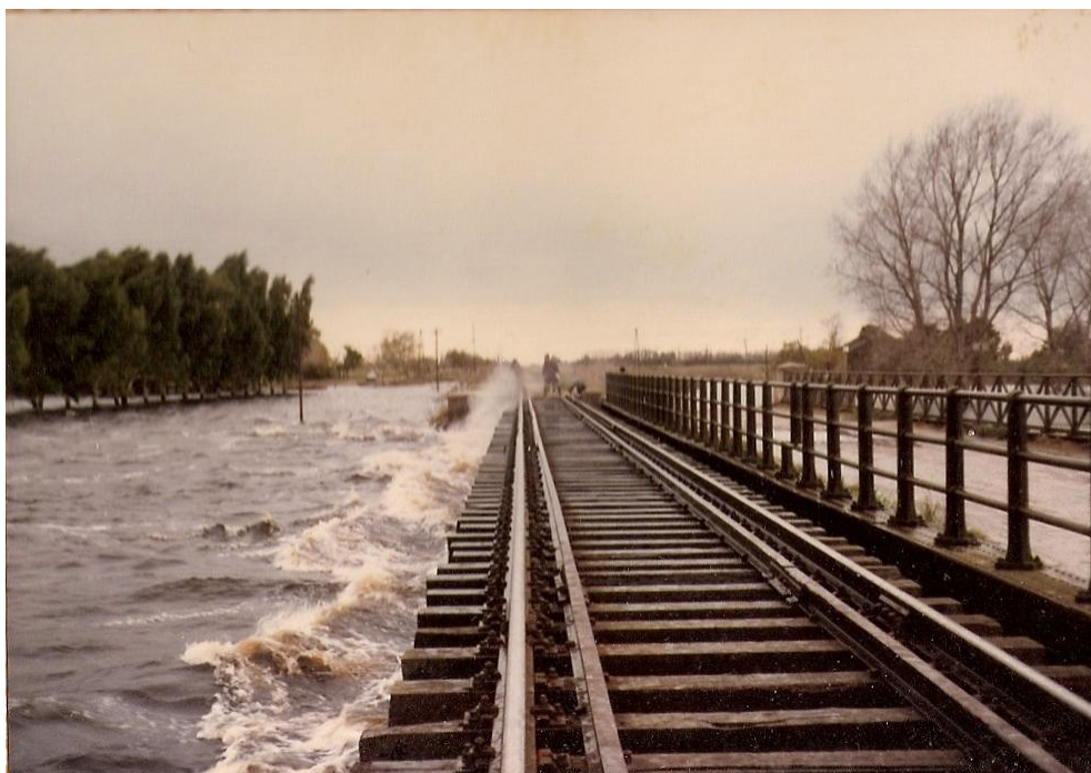
Foto 1: El nivel de agua llegó hasta la base del puente ferroviario. (Inundación de 1980)
