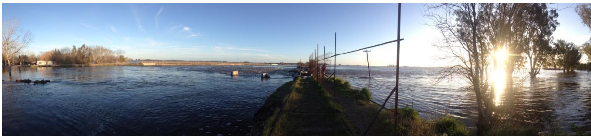
Foto 5: Panorámica desde las vías del ferrocarril. El agua llegando hasta el nivel de la traza del puente carretero (Inundación 2015).
